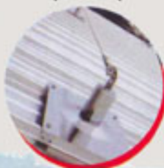
anclaje sobre cubierta tipo Kalzip
