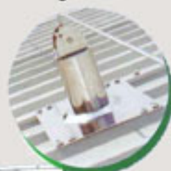
anclaje sobre cubierta grecada
